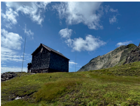
Die Böseckhütte (2594m) mit den zwei neuen Blitzableitern.
